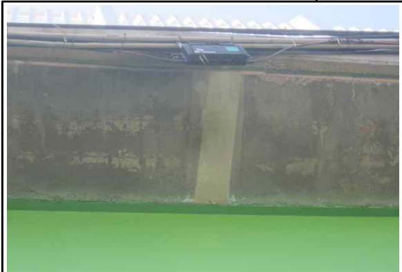
S1 캔틸레버-보수상태양호 (25년 하반기 정기안전점검)
