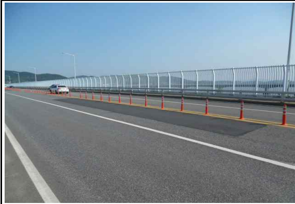
S5(강화) 교면포장-보수상태양호 (25년 상반기 정기안전점검)
