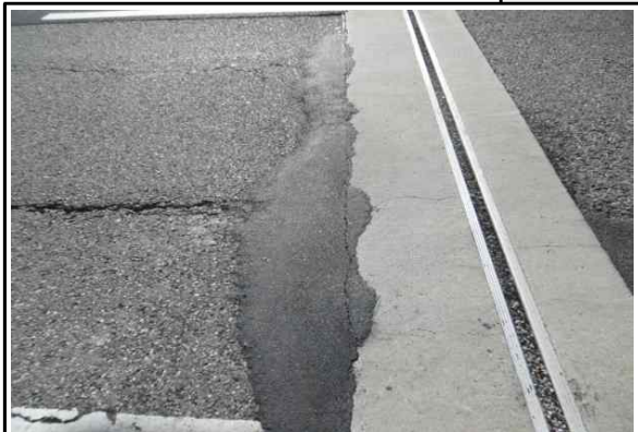
교면포장 접속부 포장 파손 보수완료 (25년 하반기 정기안전점검)
