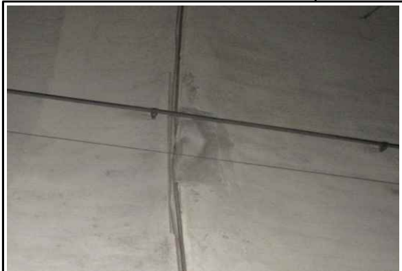
Sta. 137(Span 18) 좌측벽체-박리 (25년 하반기 정기안전점검)
