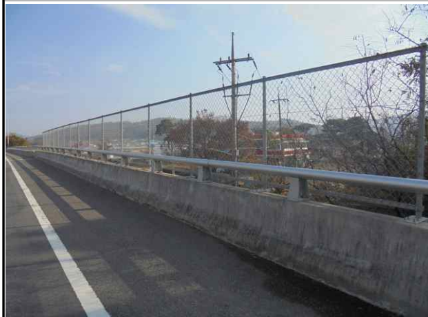
난간 및 연석 전경
