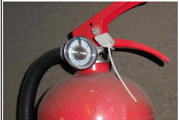
소화시설 4개소-교체완료 (25년 하반기 정기안전점검)
