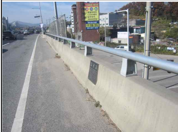
난간 및 연석 전경
