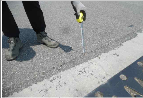
시점 접속부 교면포장-양호 (25년 상반기 정기안전점검)
