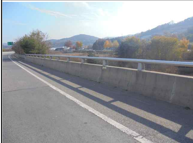
난간 및 연석 전경
