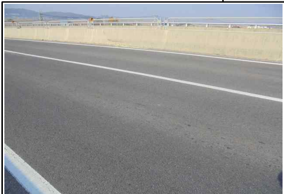
S4(1차로) 교면포장 - 보수상태양호 (25년 하반기 정기안전점검)
