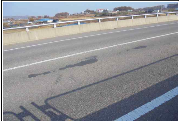
교면포장 포장 패임 보수완료 (25년 하반기 정기안전점검)
