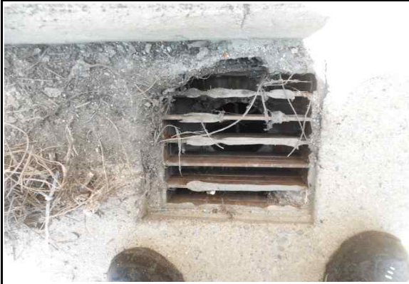
S3 배수시설-배수구 상태양호 (25년 상반기 정기안전점검)
