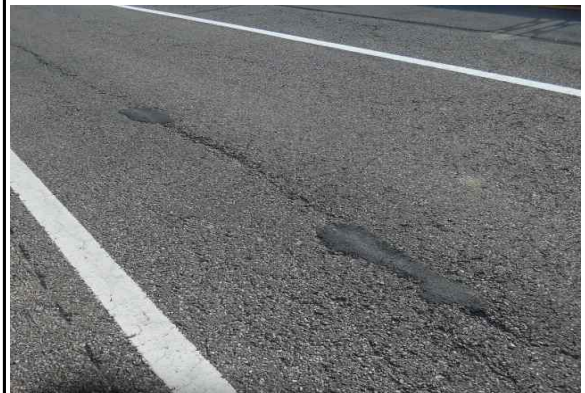
교면포장 포트홀 보수완료 (25년 하반기 정기안전점검)
