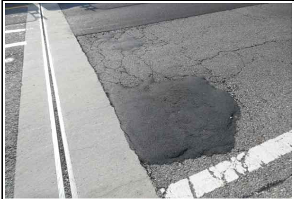
교면포장 접속부 포장 망상균열 보수완료 (25년 하반기 정기안전점검)
