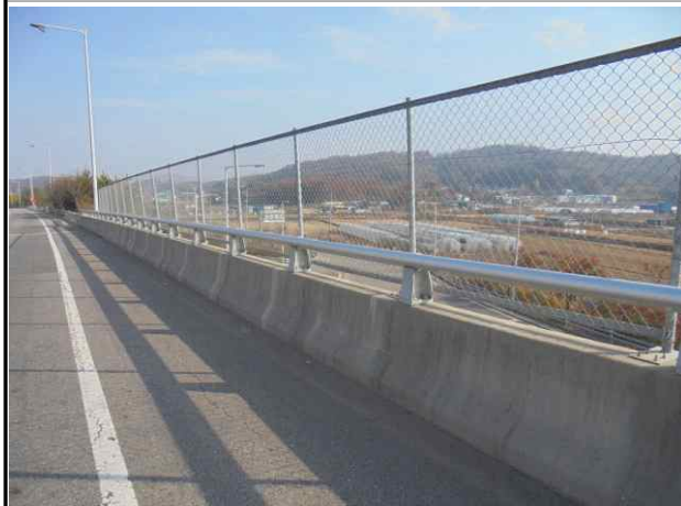
난간 및 연석 전경
