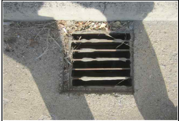
S3 배수시설-배수구 상태양호 (25년 하반기 정기안전점검)
