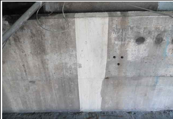
A1 교대-보수상태양호 (25년 상반기 정기안전점검)
