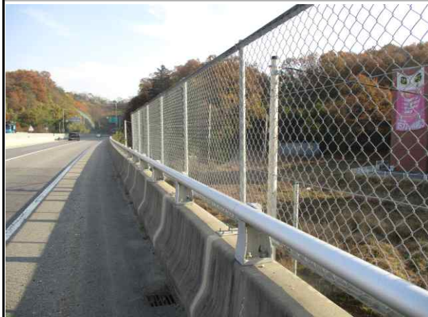
난간 및 연석 전경
