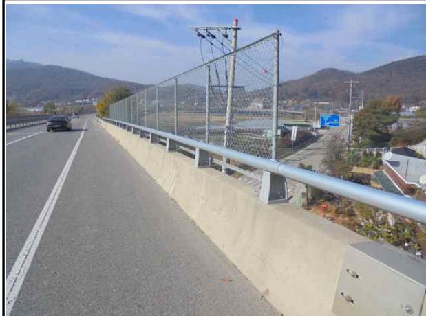
난간 및 연석 전경
