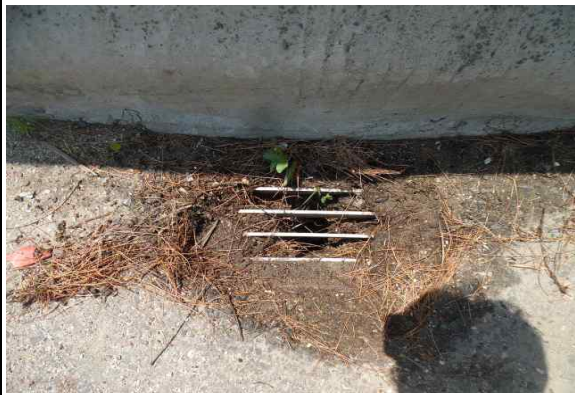
배수시설 상태양호 (25년 상반기 정기안전점검)
