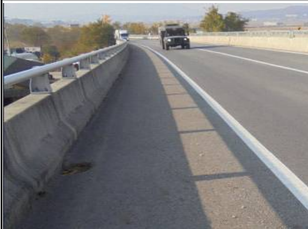
난간 및 연석 전경
