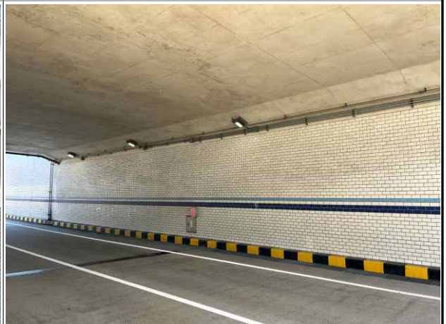
BOX 벽체 전경
