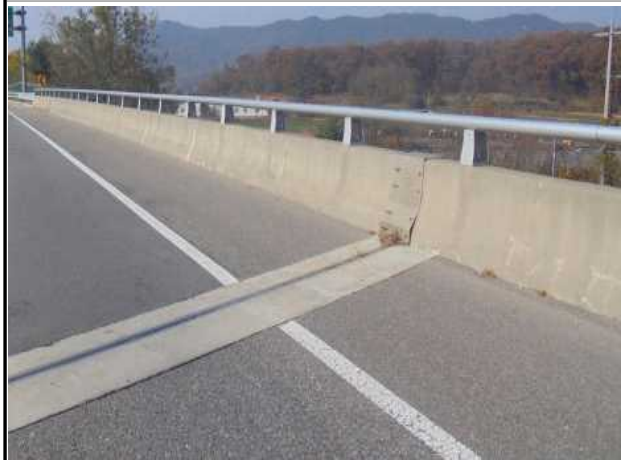
난간 및 연석 전경
