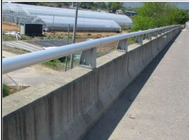
난간 및 연석 전경
