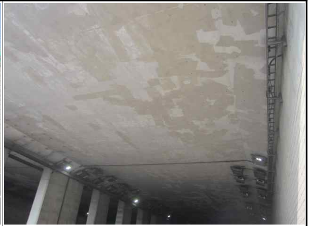
상부슬래브 하면 전경
