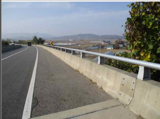
난간 및 연석 전경
