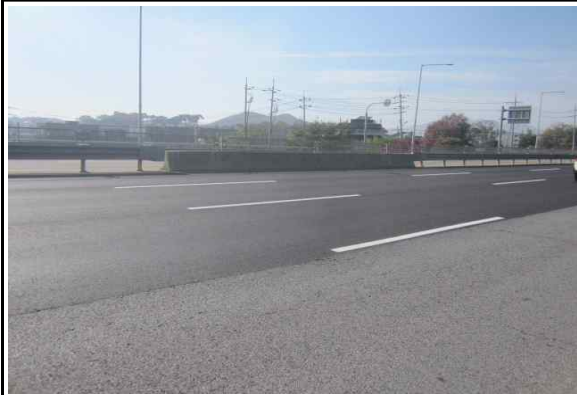
교면포장 재포장 상태양호 (25년 하반기 정기안전점검)
