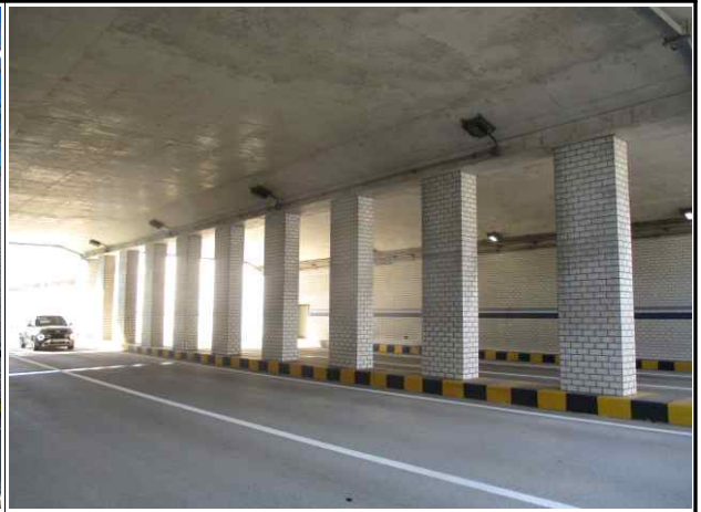
BOX 내부 전경
