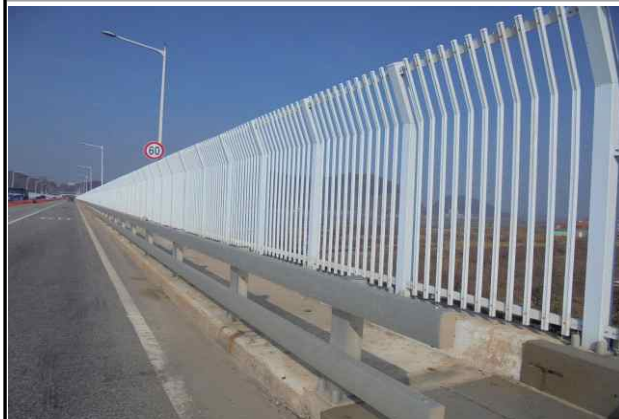
난간 및 연석 전경
