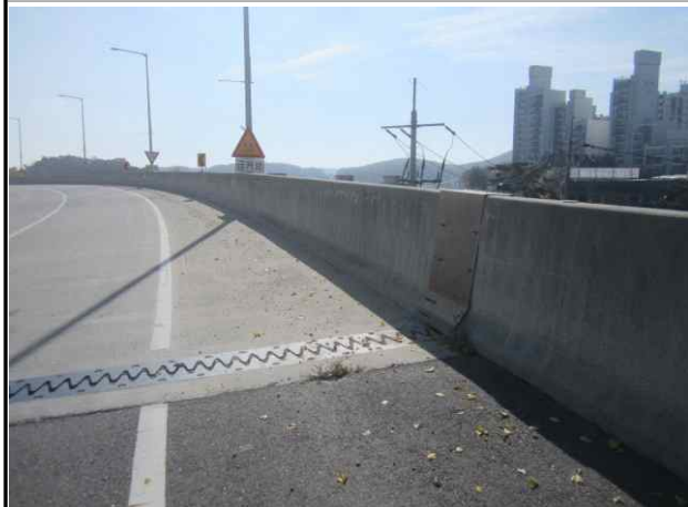
난간 및 연석 전경
