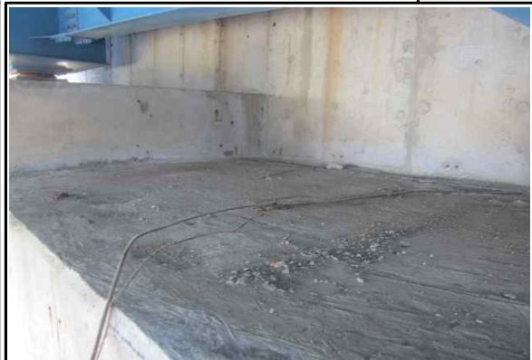
A1 교대-상태양호 (25년 하반기 정기안전점검)
