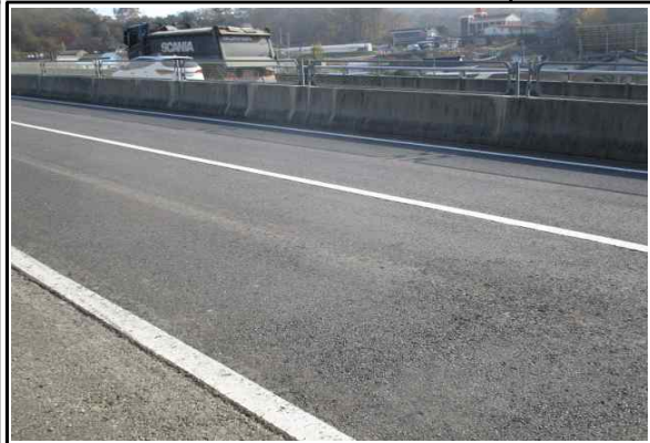
S1 교면포장-아스콘 보수상태양호 (25년 하반기 정기안전점검)
