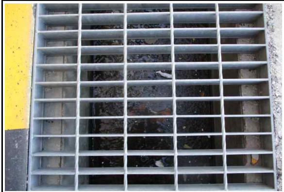
배수시설 상태양호 (25년 하반기 정기안전점검)
