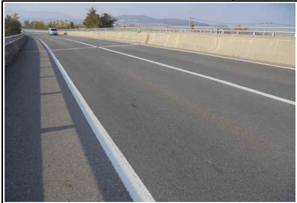
S3 교면포장-보수상태양호 (25년 하반기 정기안전점검)
