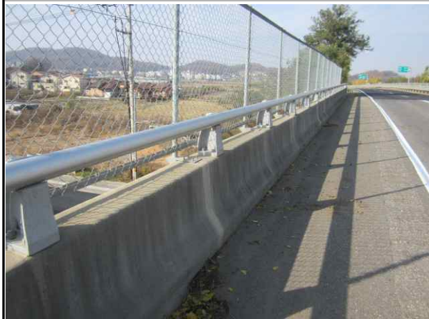
난간 및 연석 전경
