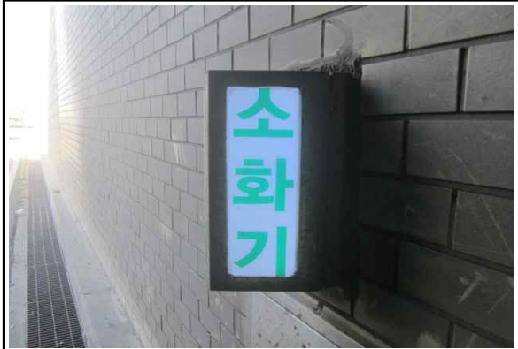
Sta. 150(강화) BOX-소화전 표시등 보수완료 (25년 하반기 정기안전점검)
