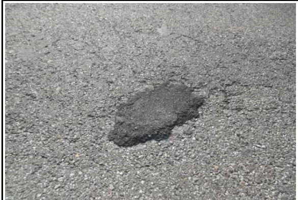
교면포장 포트홀 보수완료 (25년 하반기 정기안전점검)
