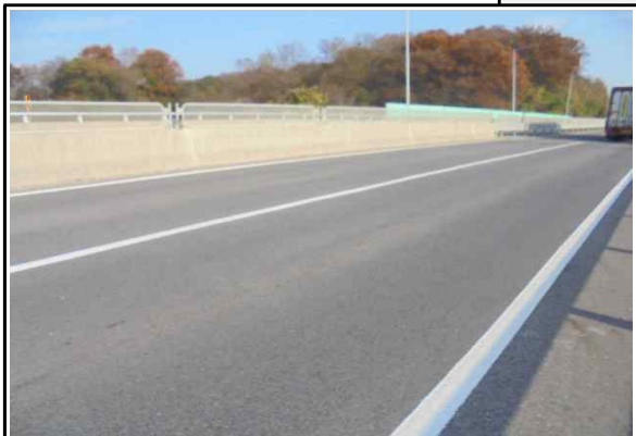
S4(1차로) 교면포장 - 보수상태양호 (25년 하반기 정기안전점검)
