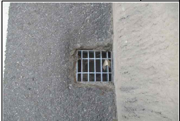
S2 배수시설-배수구 상태양호 (25년 하반기 정기안전점검)
