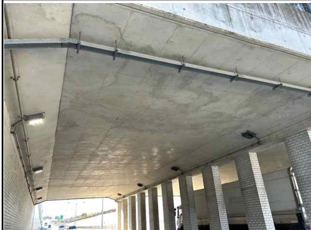
BOX 슬래브하면 전경
