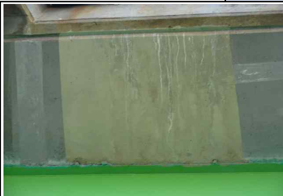
S1 캔틸레버-보수상태양호 (25년 상반기 정기안전점검)
