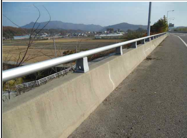
난간 및 연석 전경
