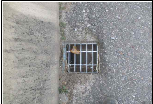
S1 배수시설-배수구 상태양호 (25년 하반기 정기안전점검)
