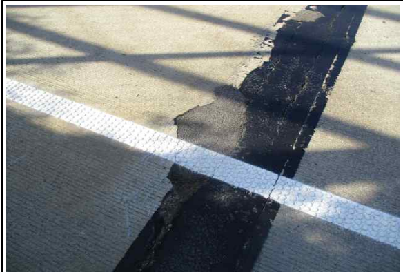
포장부 아스콘 파손 보수완료 (25년 하반기 정기안전점검)
