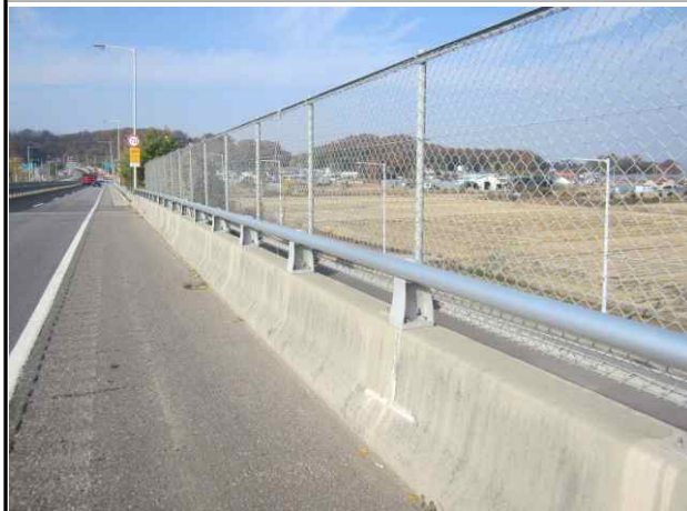
난간 및 연석 전경
