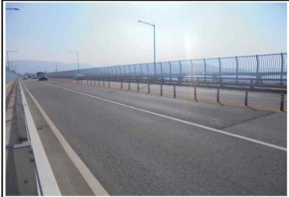
S5(강화) 교면포장-보수상태양호 (25년 하반기 정기안전점검)
