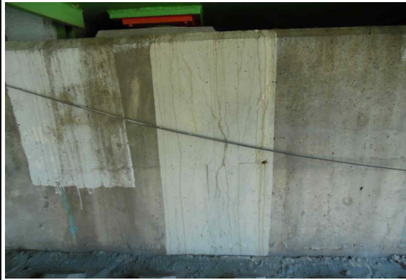
A1 교대-보수상태양호 (25년 상반기 정기안전점검)
