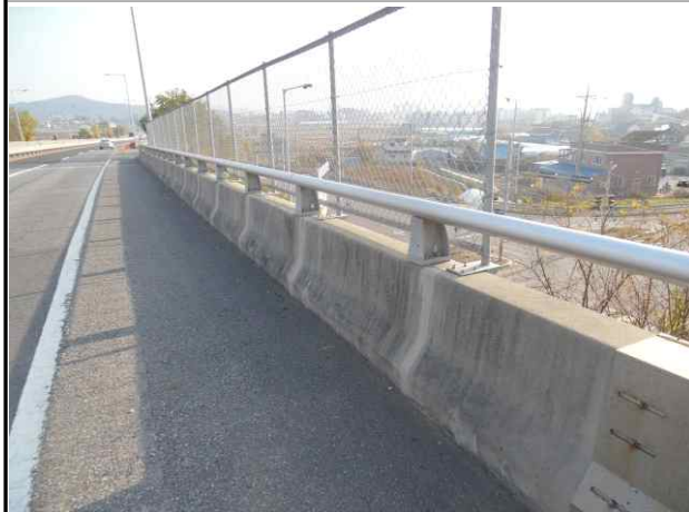
난간 및 연석 전경
